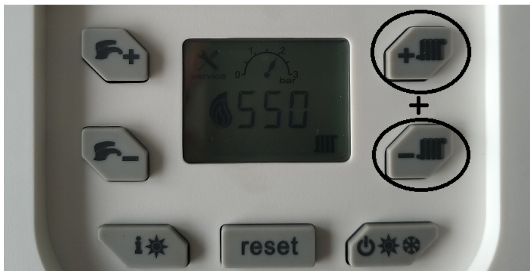
Панель управления котла
